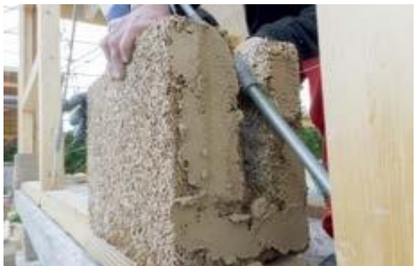
Exemplu de aplicare CANAPAMALTA pe cadru din lemn cu structuri antisismice
