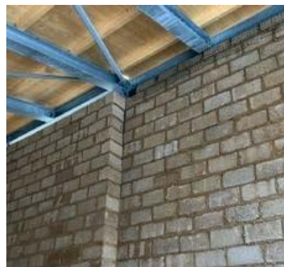
CANAPAMALTA în combinație cu cadru metalic și acoperiș din lemn
