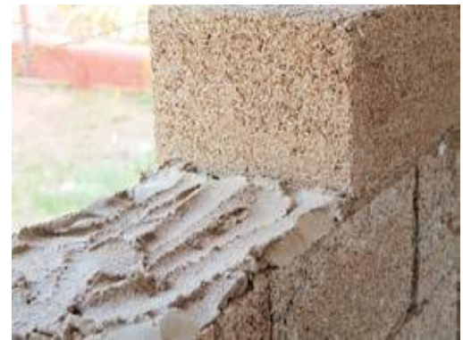
Aplicare CANAPAMALTA cu CANAPLOCK
