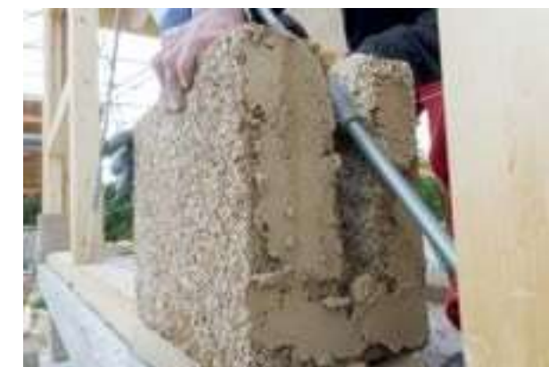
Exemplu de instalare CANAPLOCK pe cadru din lemn cu structuri antiseismice.
