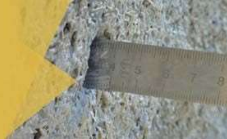
EXEMPLU DE TENCUIALA CU GROSIME PE UMLUTURA EXISTENTA
