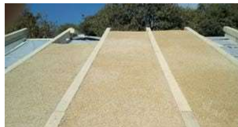
Sapa pentru izolare acoperis cu CANAPAMAS 385 kg/mc
