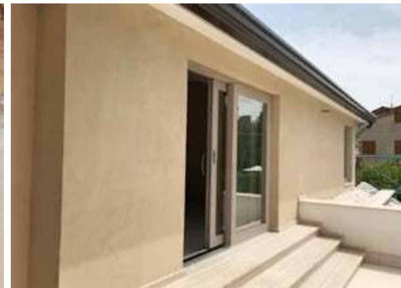
Rasatura externa con CANAPASTUCK al naturale
