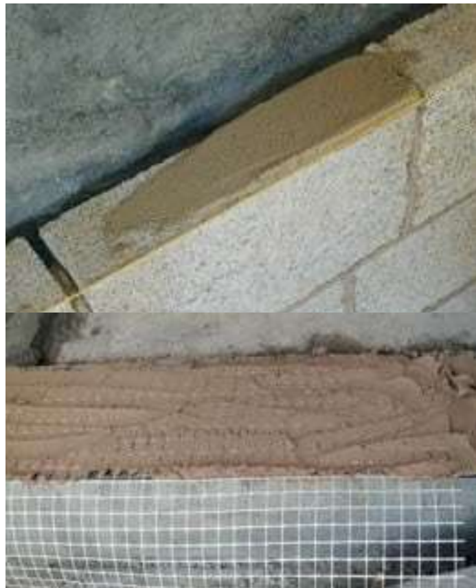
Mortar aplicat pe plasa de sustinere (montare la sol)
