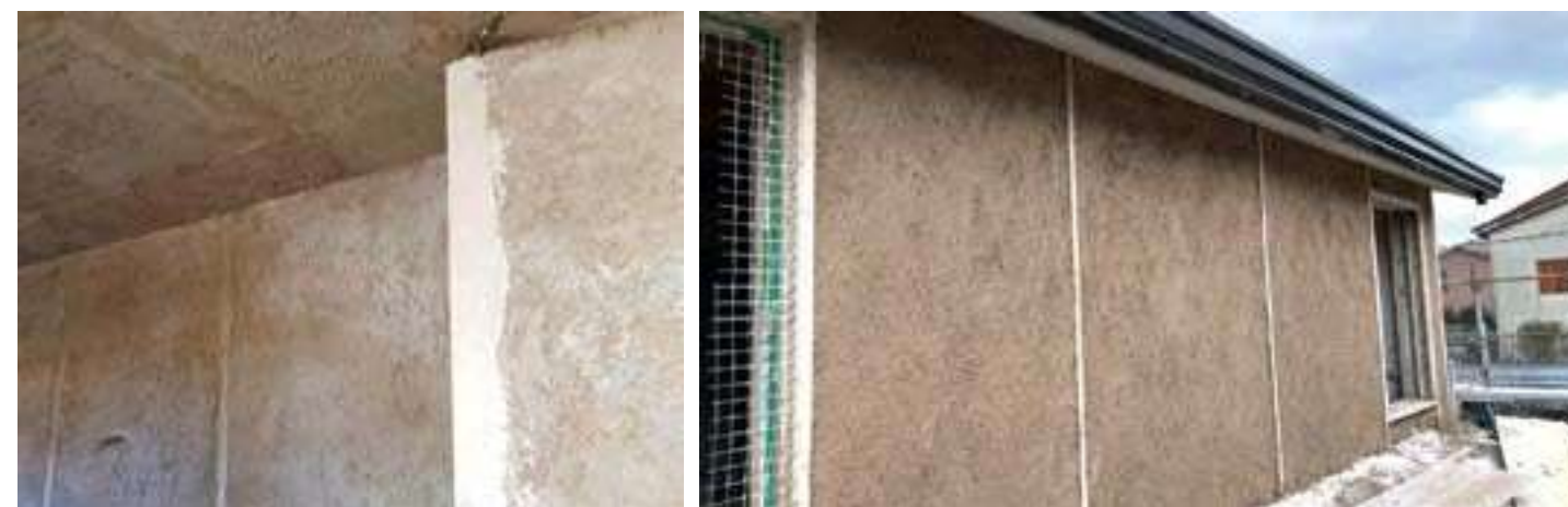
Exemple de tencuieli interne si externe, realizate cu CANAPAMIX termoacustica
