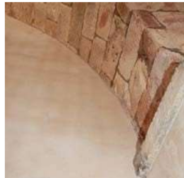
Finisare interna cu CANAPASTUCK natural
