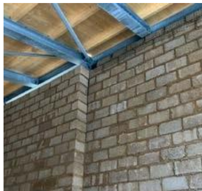
CANAPLOCK în combinație cu cadru metalic și acoperiș din lemn
