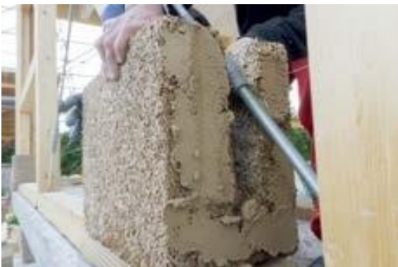
Exemplu de instalare CANAPLOCK pe cadru din lemn cu structure antisismice
