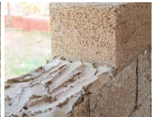
Aplicare CANAPLOCK cu CANAPAMALTA
